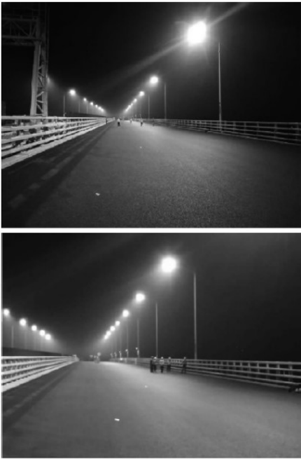
图 9 港珠澳大桥主线桥梁道路照明效果实拍
